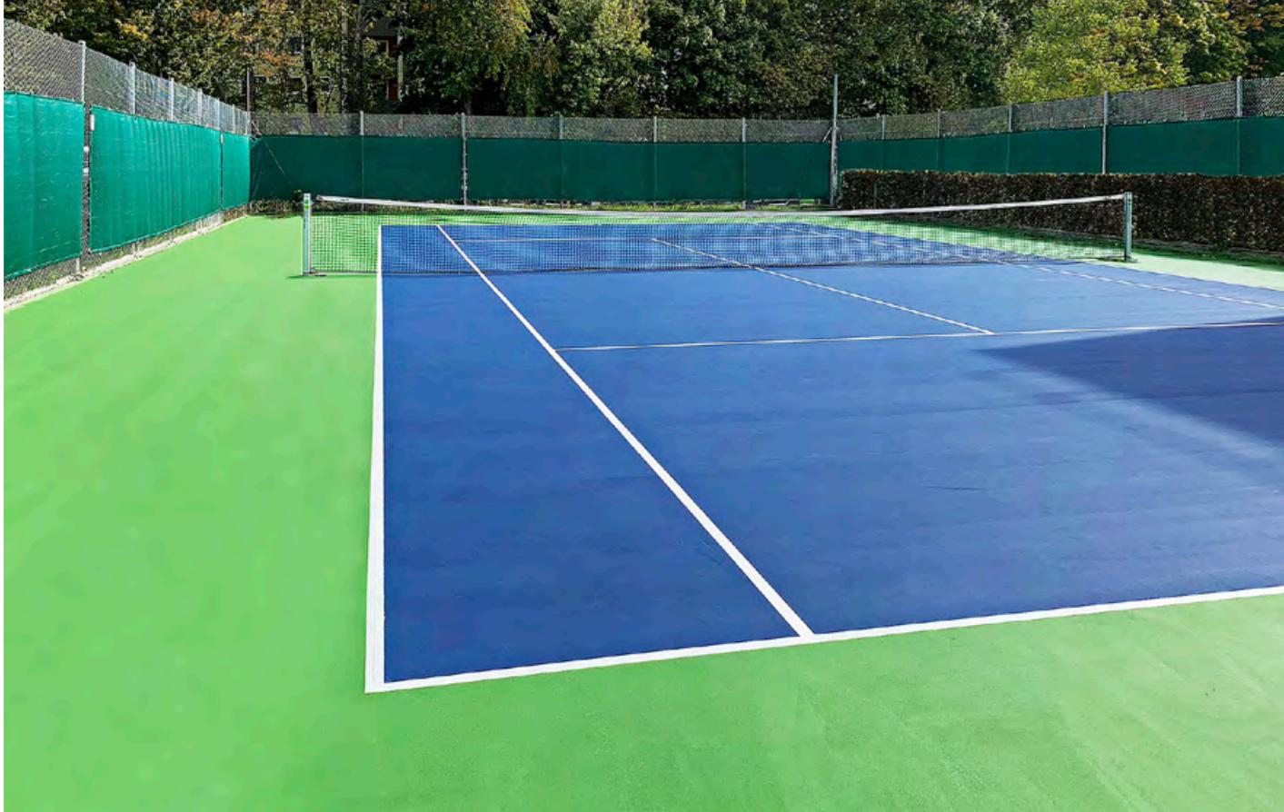
Für jedes Wetter: Acrylbelag mit gelenkschonender elastischer Tragschicht (ca. 5 – 8 mm)
