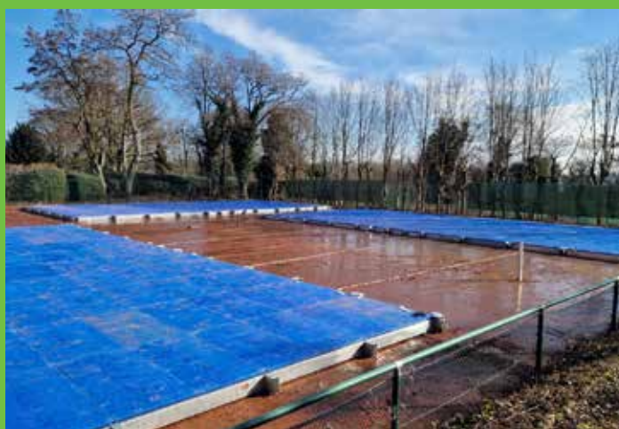
Auch beim WTCD werden aktuell drei Padelplätze errichtet. Auf den alten Tennisplätzen 6 und 7 stehen bereits die Basiselemente.
