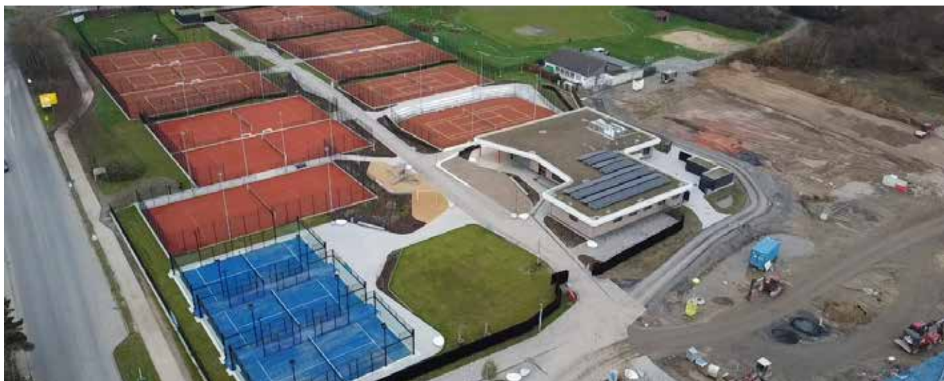
Unweit von Vater Rhein liegt die neue Sportanlage vom Tennis- und Padelclub Monheim.
