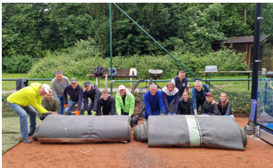
Die Padelplätze werden in Gemeinschaftsarbeit fertiggestellt.
